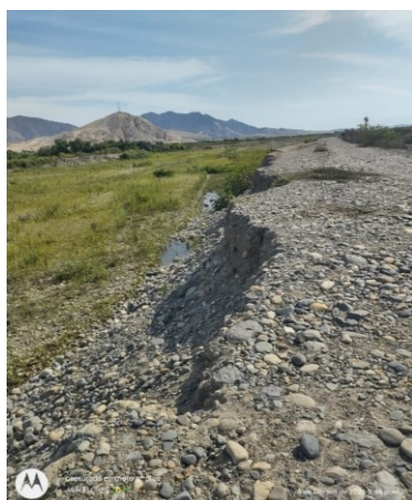
FIGURA N°02.- EN LA FOTOGRAFIA EL DIQUE DE LA MARGEN DERECHA HA SIDO EROSIONADO POR EL AUMENTO DEL CAUDAL DEL RIO NEPEÑA
